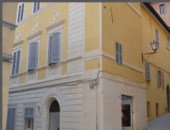
Particolare PALAZZO COSTA INCROCIATA, Siena (SI)
