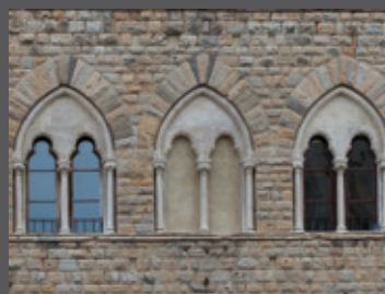
Particolare PALAZZO PIAZZA DEI PRIORI, Volterra (PI)
